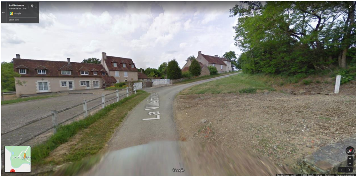
Figure 20 : Extrait Google Street-View au niveau du hameau de Villefranche, montrant que la topographie et la végétation arborée filtrent largement les vues en direction des éoliennes projetées
