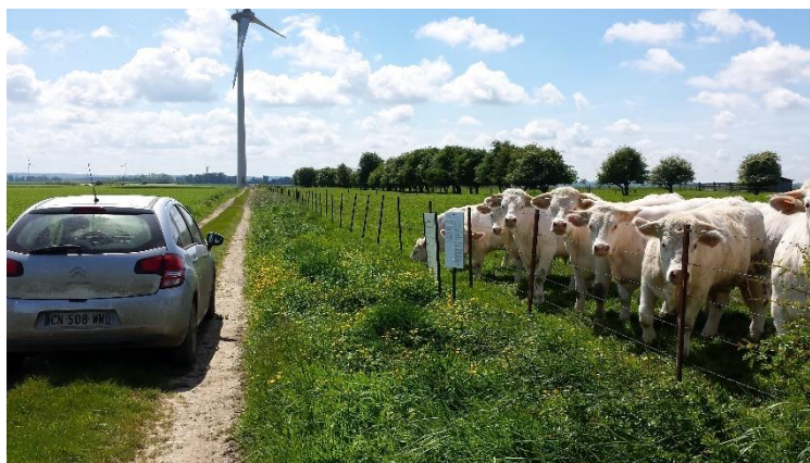
Figure 7 : Photographie du parc éolien de Coin Malo (2014, Vol-V Electricité Renouvelable)
